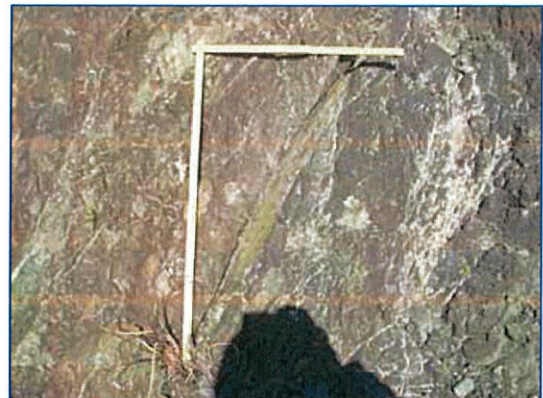
写真 5：切土法面中段における F5 断層とその 北西部断層の結合部状況。
