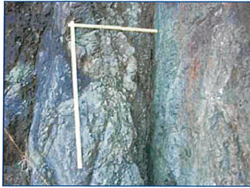
写真 3：計画地内の F5 断層 の破砕部の状況
